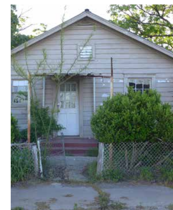
Caretaker's house / Casa del Cuidador
